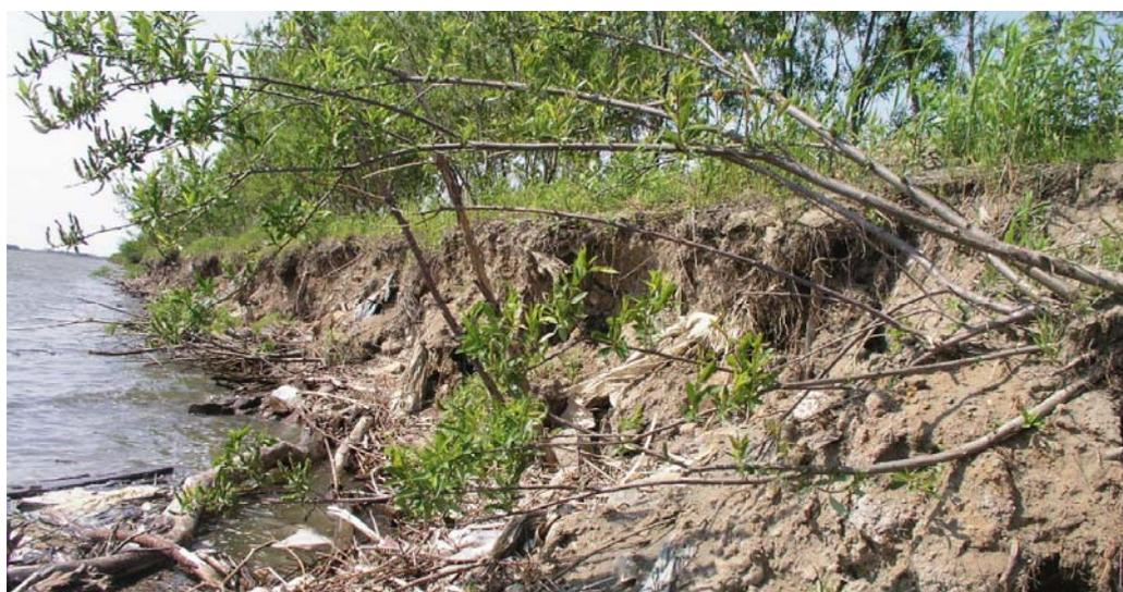
写真2-1 河岸の崩落状況
