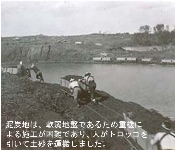
写真 1-2 夕張川の直線化（新水路の掘削）
