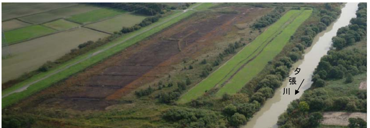
写真 1-1 幌向地区の現況（平成 24 年 10 月撮影）
