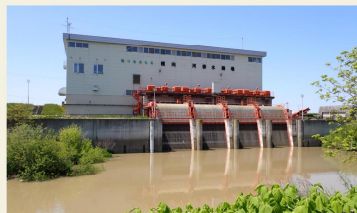
幌向運河排水機場
