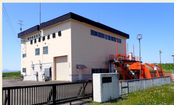
西長沼排水機場
