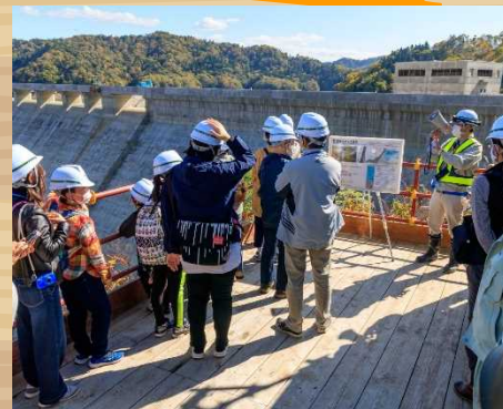
建設中の新桂沢ダム
