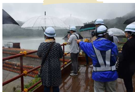
工事状況の説明
