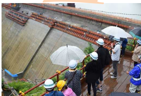
工事状況の説明
