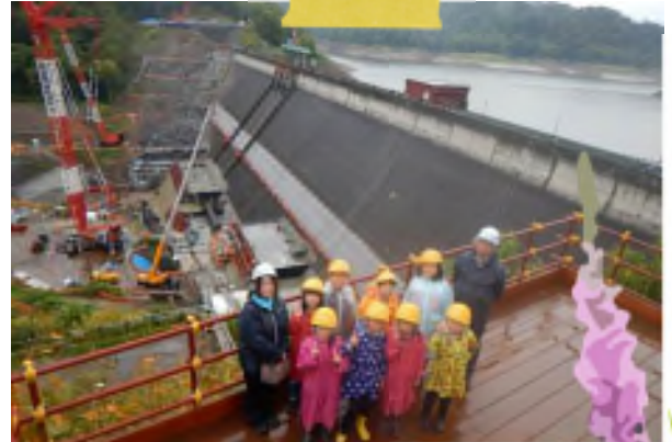
新桂沢ダムの工事も見ってきました
