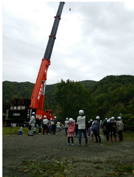
北海道内に 3 台しかない 550t 級大型クレーン
