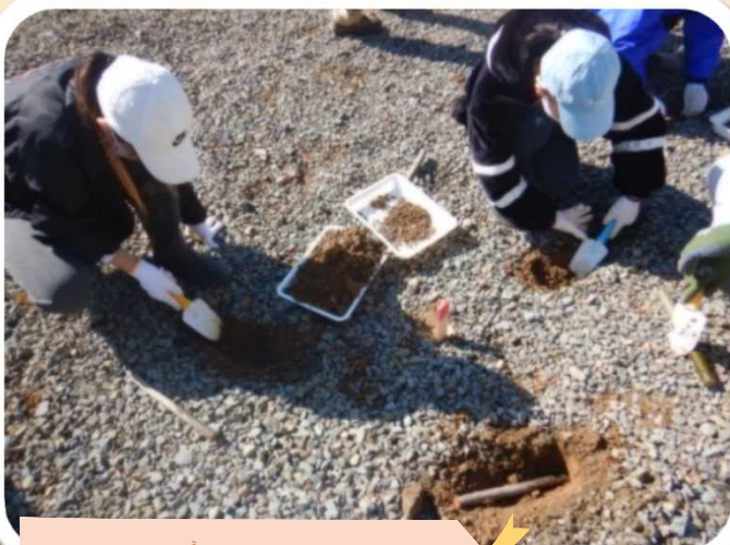
枝を埋める作業
