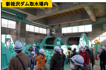
新桂沢ダム取水塔内
