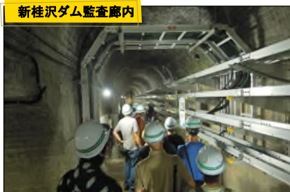
新桂沢ダム監査廊内
