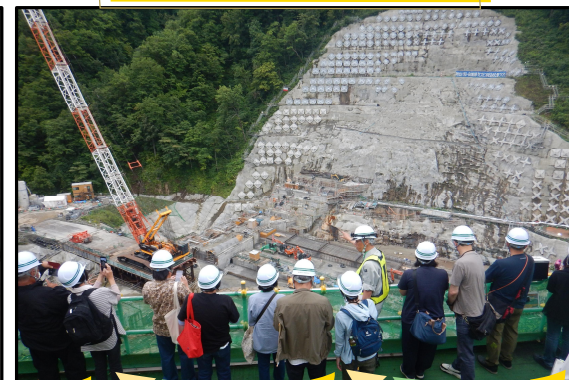
三笠ぽんべつダム建設予定地
