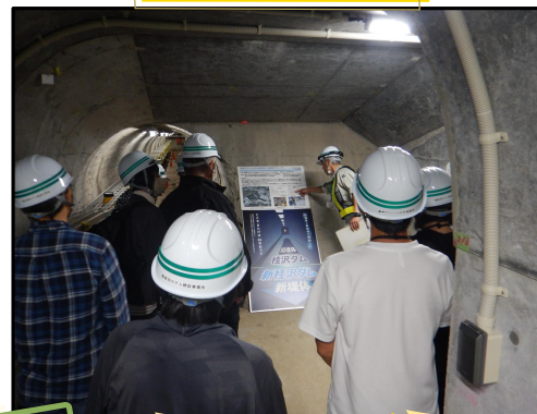
新桂沢ダム監査廊内
