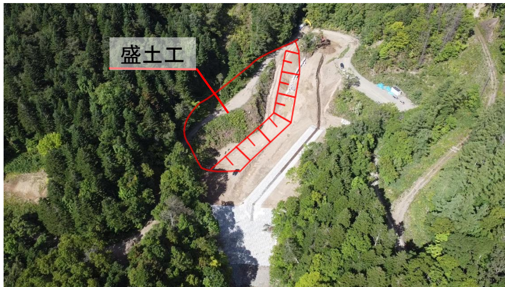
3-10地すべり対策工 盛土工(R3.7撮影)
