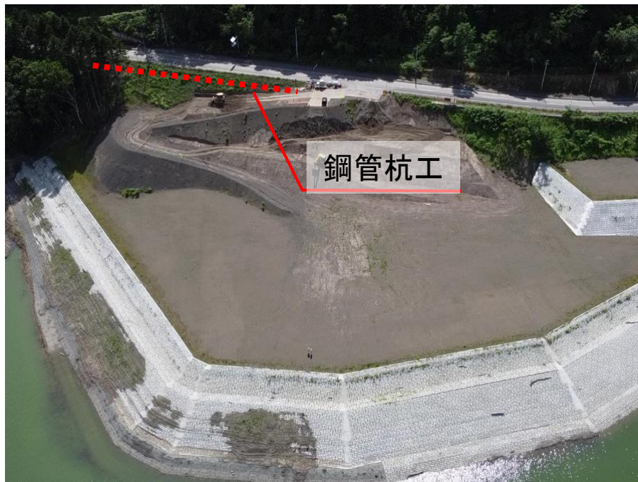
2-19地すべり対策工 鋼管杭工(R3.7撮影)
