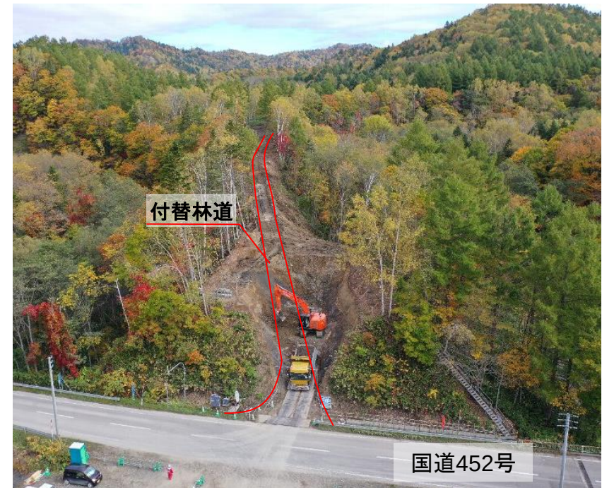
左股沢付替林道 掘削(R3.10撮影)
