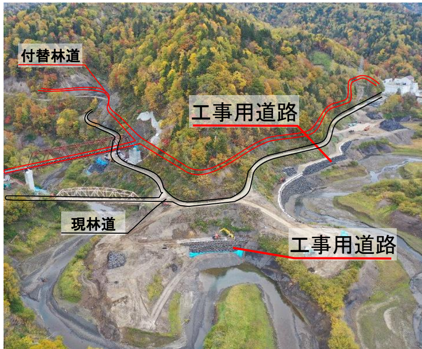
桂沢No.1付替林道 工事用道路(R3.10撮影)
