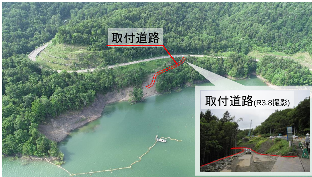
2-7B地すべり対策工 取付道路(R3.6 撮影)
