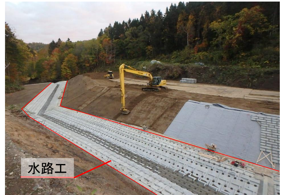
3-10地すべり対策工 水路工(R3.10撮影)
