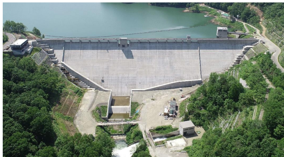
新桂沢ダム堤体本体 令和3年6月撮影
