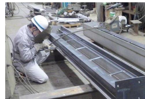
ゲート溶接 令和3年8月撮影
