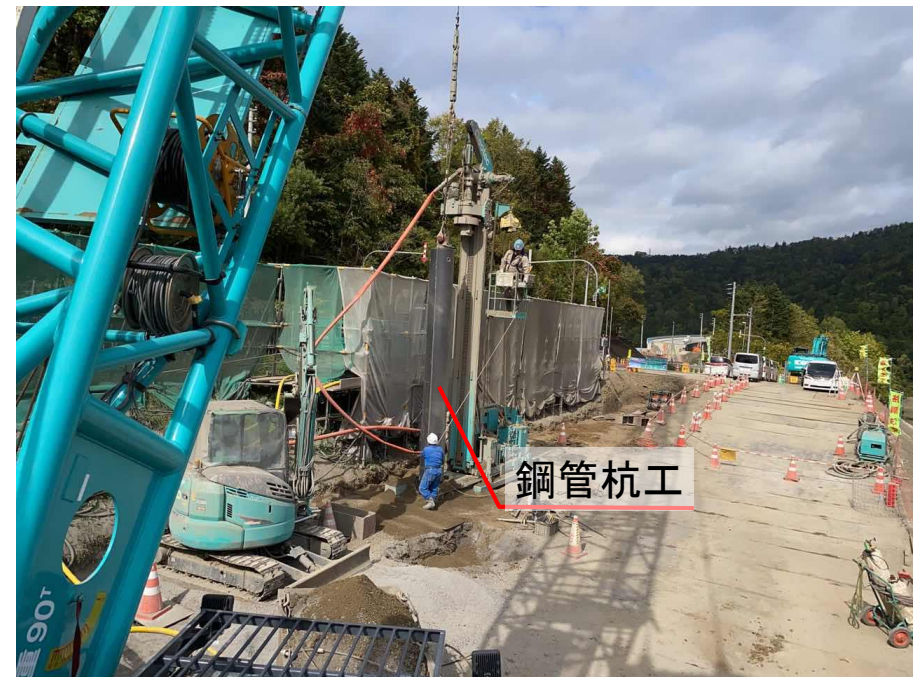
2-19地すべり対策工 鋼管杭工(R3.9撮影)
