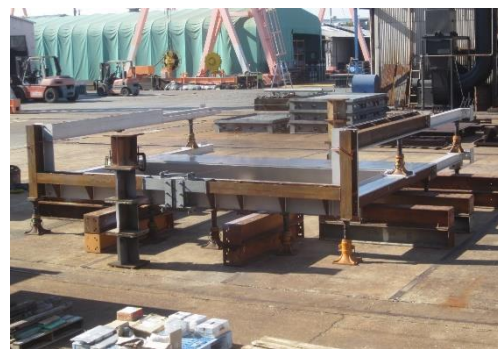
ゲート仮組み 令和3年8月撮影
