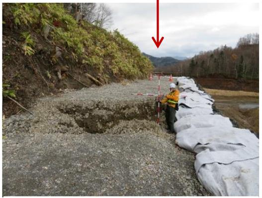
上流面の路面亀裂(高低差約1.2m)
