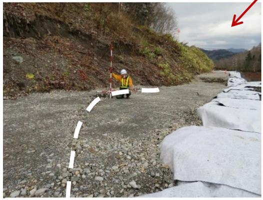
下流面の路面亀裂(高低差約0.25m)
