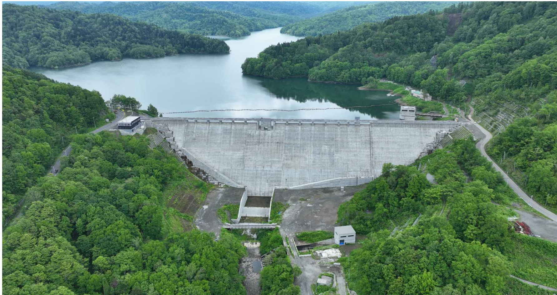
新桂沢ダム堤体本体 令和4年6月撮影
