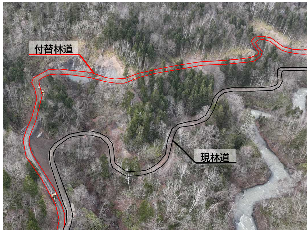
熊追沢No.2付替林道 掘削工 盛土工 排水工 (R4.11撮影)
