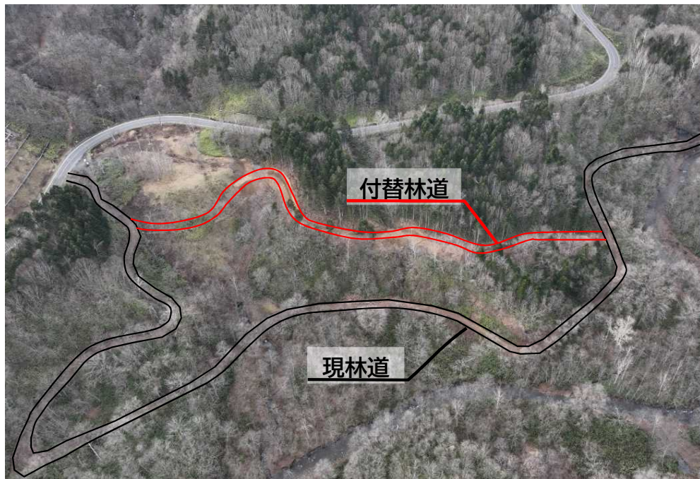
上一の沢付替林道 掘削 (R4.11撮影)
