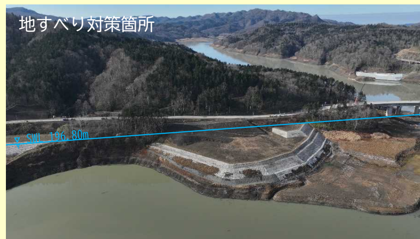
貯水池周辺地すべりブロックや斜面の変状 等
