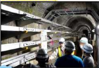
新桂沢ダム監査廊内
