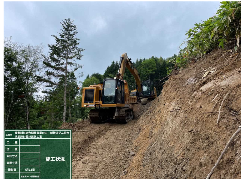
熊追沢No.2付替林道 施工状況 (R5.7撮影)
