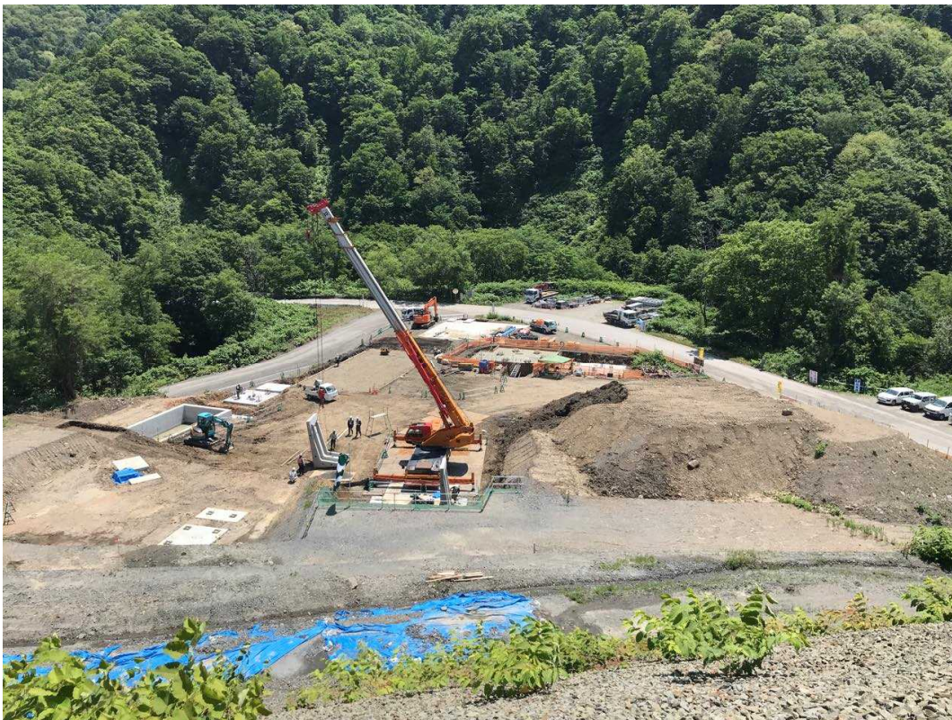
施工設備仮設工 (R5.7撮影)
