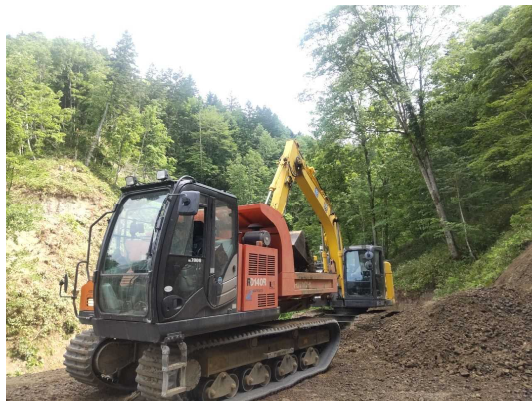
幾春別No.2付替林道 掘削工 (R5.6撮影)
