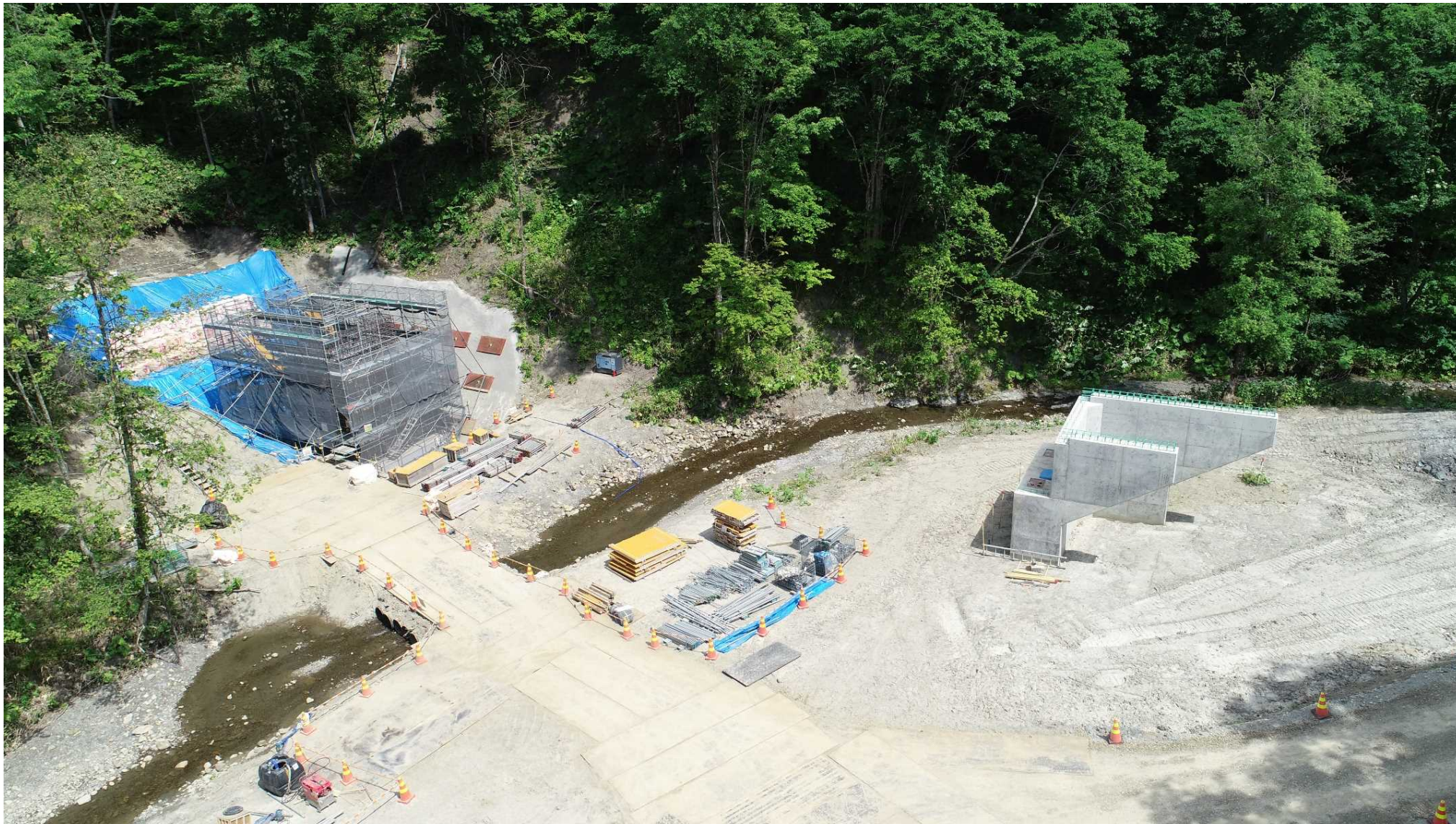
幾春別No.3付替林道 橋梁下部工 (R5.6撮影)
