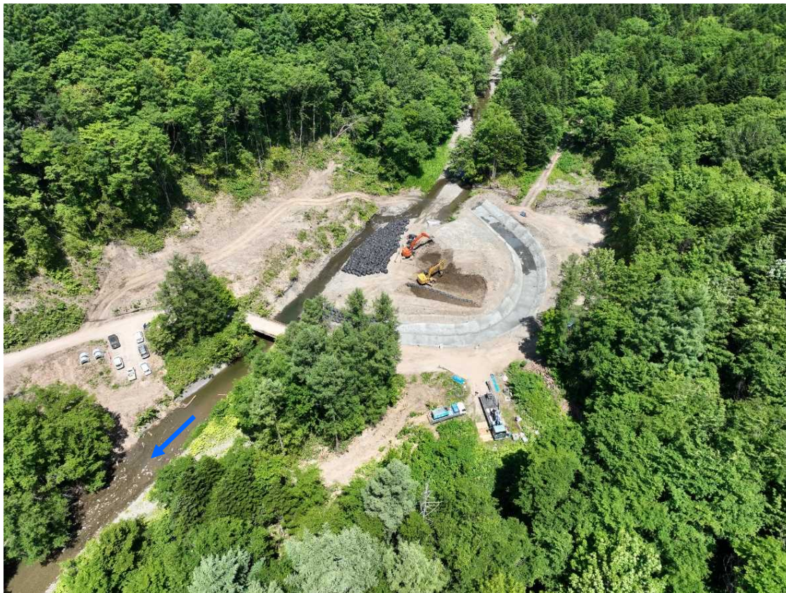
橋梁工事 (R5.7撮影)
