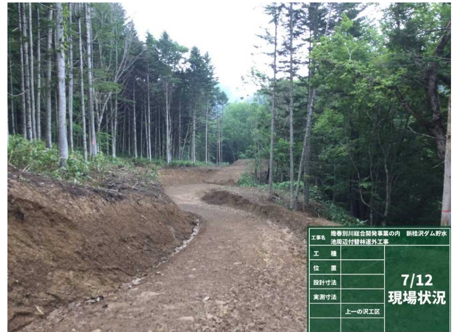
上一の沢付替林道 状況写真 (R5.7撮影)
