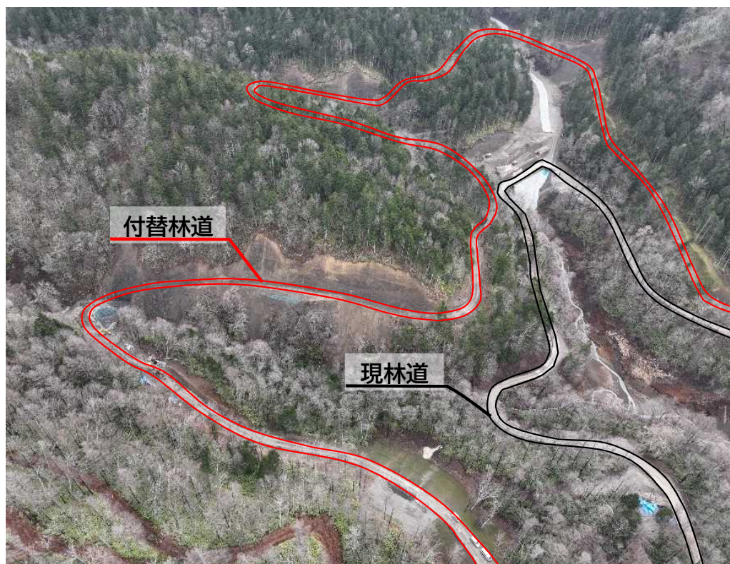
幾春別No.2付替林道 掘削工 (R4.11撮影)
