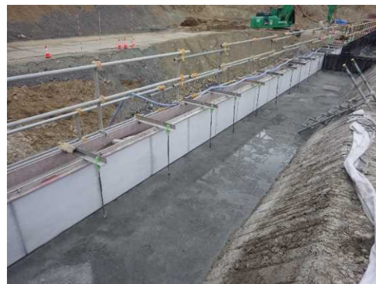
置き型枠による堤体表面と設置例
