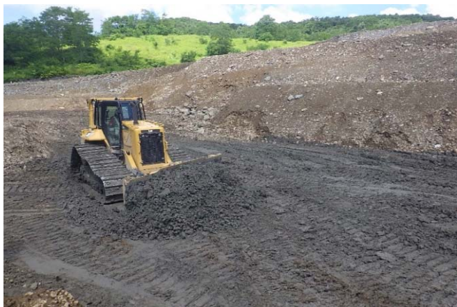
【脱水ケーキ敷均し】
