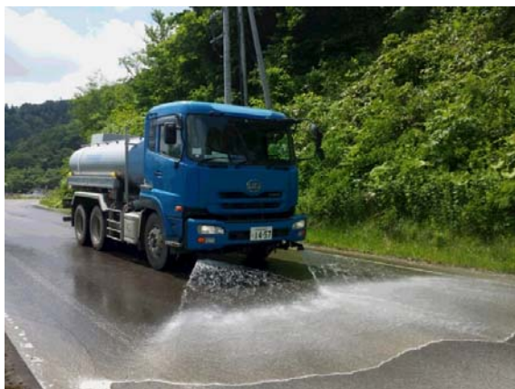
【工事用道路への散水】
