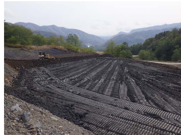
【前処理沈砂池スラッジ敷均し】
