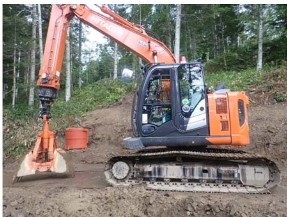
【騒音：低騒音型建設機械の採用】
