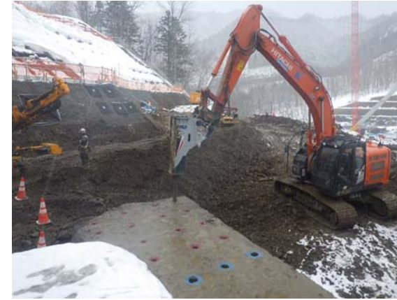
【振動：作業方法の改善(低振動工法の採用)】
