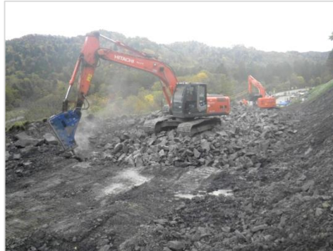
変更 硬岩掘削(大型ブレーカー+バックホウ掘削)
