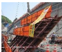
スライド型枠設置撤去
