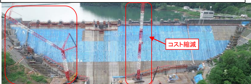
コンクリート打設期間の延伸に伴うクレーン等打設機械賃料の増
