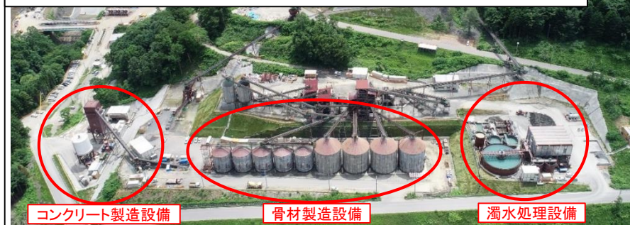
コンクリート打設期間の延伸に伴い仮設備設置期間(損料)が追加
