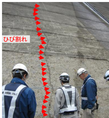
既設堤体下流面のクラック
