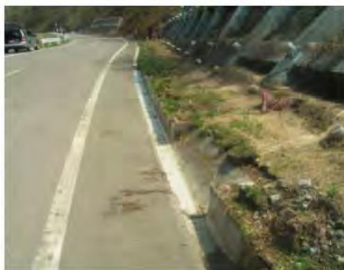
写真 2.4-1 動物の移動に配慮した側溝
