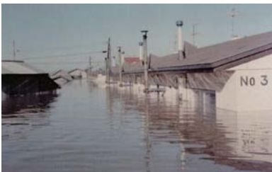
昭和50年 北村 浸水中の公営住宅 豊里団地 ③
