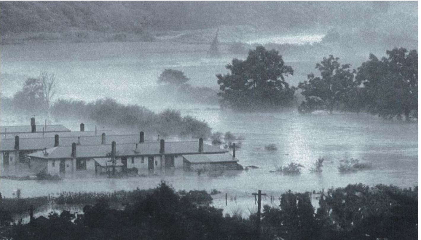
昭和41年8月 集中豪雨により床上浸水となった公営住宅 三笠市堤町 ①
