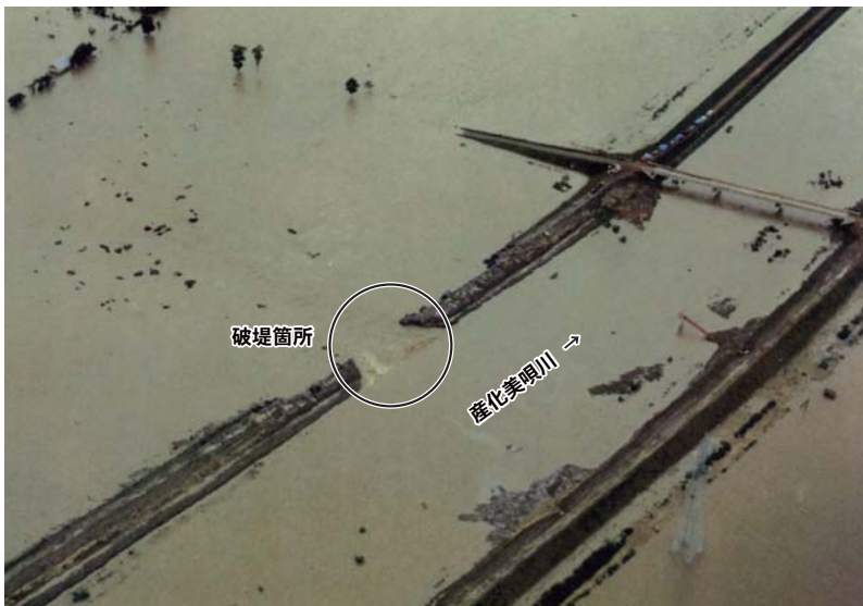
昭和56年8月 産化美唄川左岸7号線橋上流(石狩川流域発展の礎・治水より) ③
