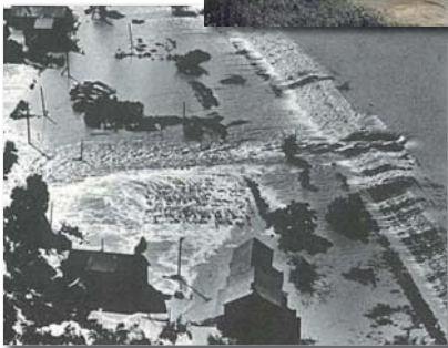
大曲左岸築堤の越水破堤状況(石狩川左岸) ②
