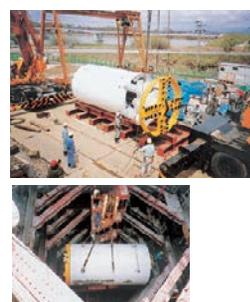
トンネルはシールド掘進機で掘削。
