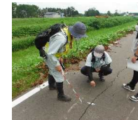
亀裂(堤防点検)
