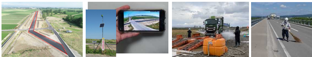
工事用道路の造成（一般交通との分離） 工事用道路の遠隔監視 タイヤの清掃（湿式スパツ） 橋の清掃
