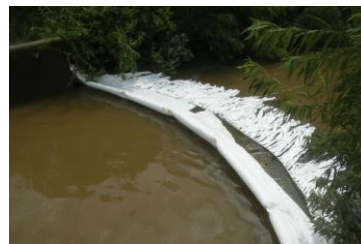
オイルフェンス設置状況
