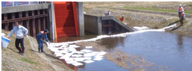
オイル吸着マット設置状況
