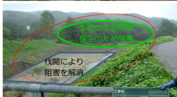
樹木管理のための伐開工事の例
