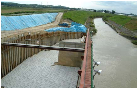
▲川向頭首工に建設中の魚道
