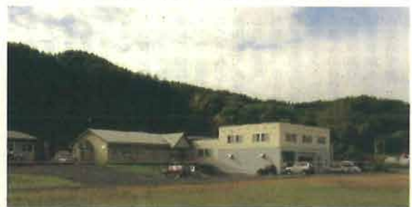
幾春別川ダム建設事業所(三笠市幾春別山手町)
