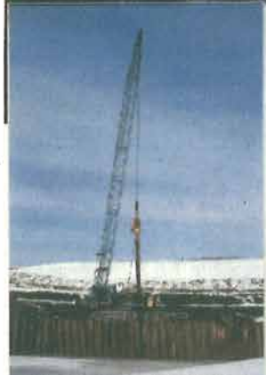
仕切っていた鋼矢板が抜かれました
