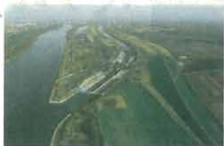
工事中の新水路(石狩川との合流点)
