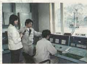
①ここでダムのゲート操作をします。右のテレメータからの情報でダムに入ってくる水の量がわかるんですって!
