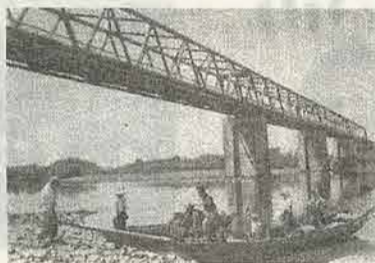
岩見沢大橋と渡船 (新篠津村史より)
