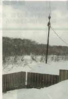
鋼矢板の撤去
