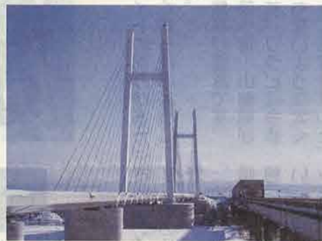
斜張橋の「たつぷ大橋」と「岩見沢大橋」(右)
