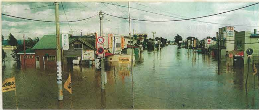
昭和56年の水害で冠水した北村。農協前から役場方向の眺め(8月6日)
