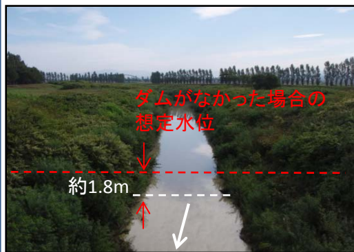
新川橋より上流方向(西川向水位観測所付近)
