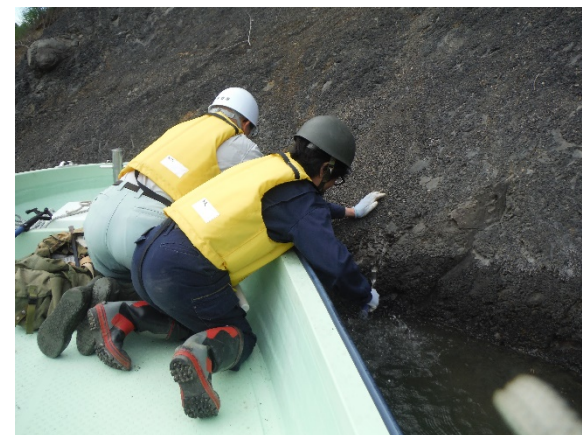
湖岸部巡視状況
