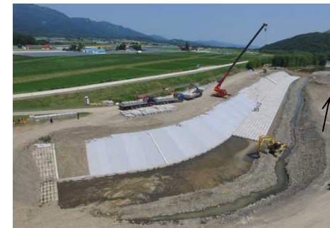
低水護岸工施工状況
