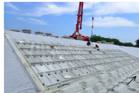
低水護岸工施工状況
