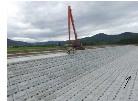
高水護岸工施工状況
