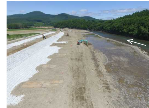
低水護岸工覆土状況
