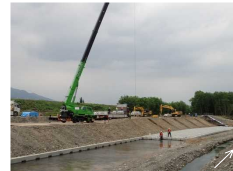
根固め工施工状況
