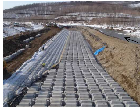
低水護岸工施工状況
