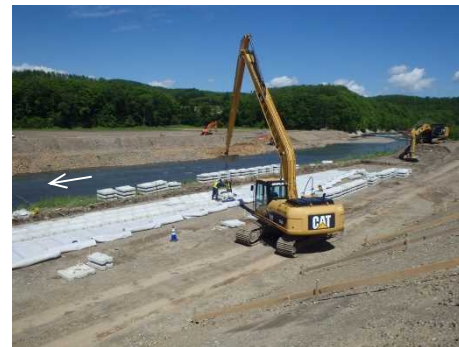
高水護岸工施工状況
