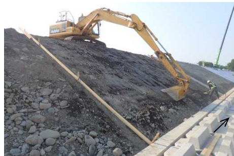
低水護岸法面施工状況
