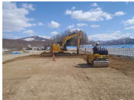
堤防盛土施工状況
