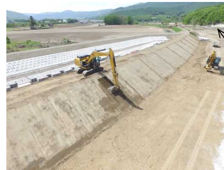
堤防法面施工状況
