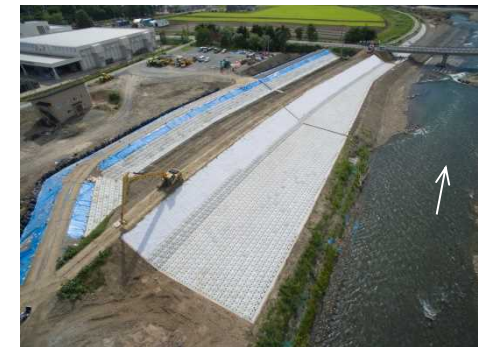
高水護岸工完了
