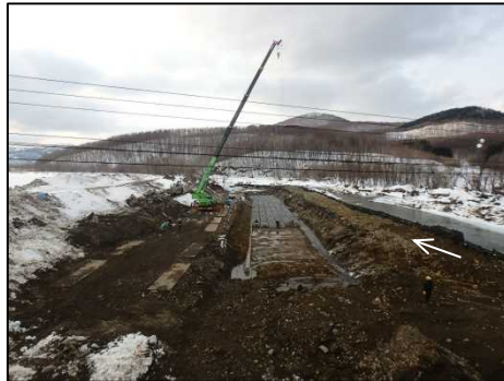
根固め工設置状況
