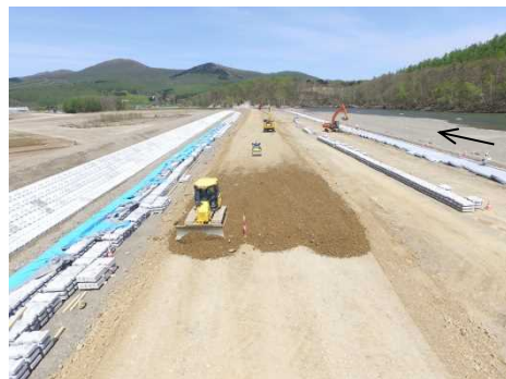
堤防盛土施工状況
