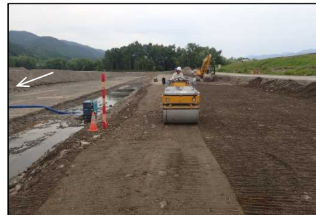
盛土工施工状況
