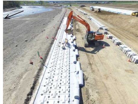
低水護岸工施工状況
