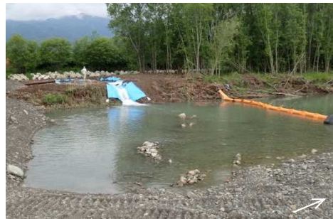
仮締切設置状況
