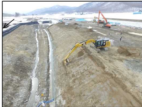
低水護岸工施工状況
