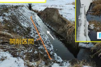
新水路開削箇所
