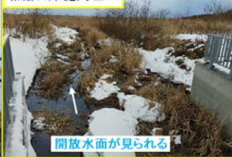
嶮淵右岸樋門吐口
