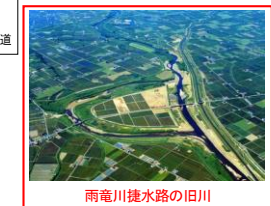
雨竜川捷水路の旧川
