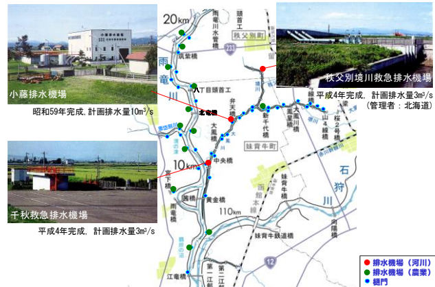
図 1-10 内水排水施設
