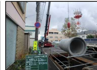
下水道雨水管の整備
