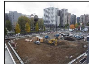
流域貯留施設の整備
