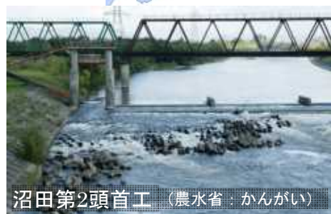
(昭和37年; 堰高H=1.25m) 最大取水量0.621m 3 /s
