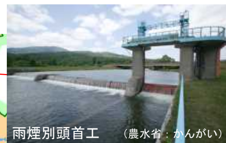
(昭和42年; 堰高H=1.65m) 最大取水量2.316m 3 /s
