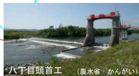
(昭和42年; 堰高H=1.24m) 最大取水量1.917m 3 /s
