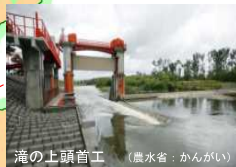
(昭和40年; 堰高H=2.0m) 最大取水量15.984m 3 /s
