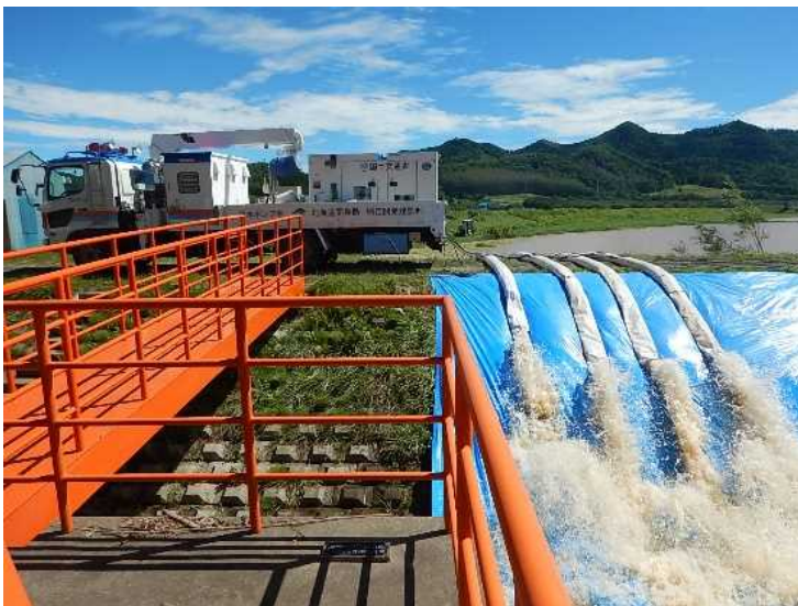
(参考) 排水作業の様子 (平成28年8月洪水時)
