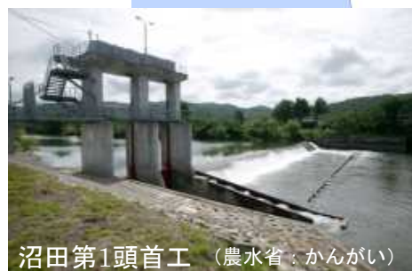
(昭和29年; 堰高H=3.0m) 最大取水量3.115m 3 /s
