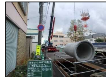
下水道雨水管の整備
