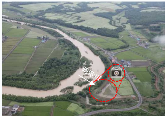
雨竜川KP.46左岸(深川市)
