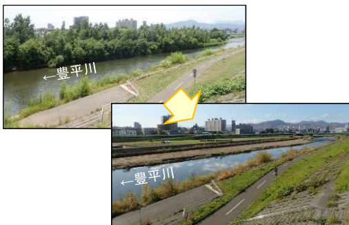
豊平川治水対策の促進 (河道掘削・樹木伐採)
