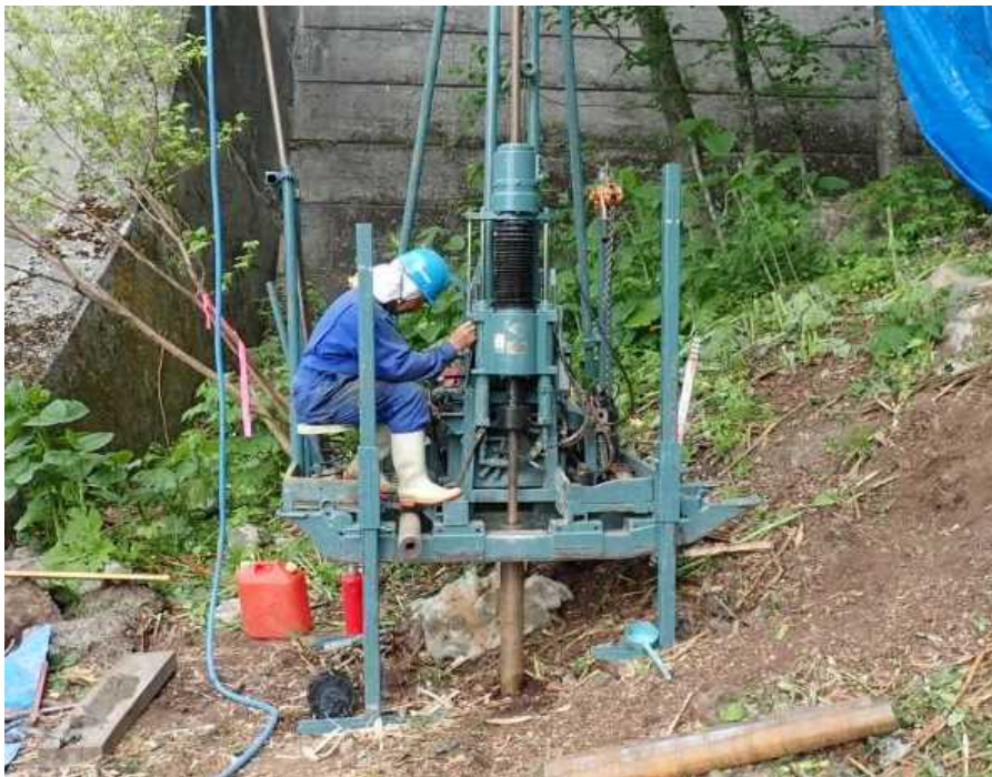
地質調査状況(ボーリング調査)
