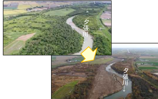
夕張川治水対策の促進 (河道掘削・樹木伐採)
