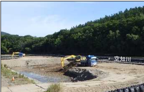
空知川治水対策の促進 (河道掘削・堤防整備)
