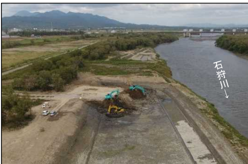
石狩川上・中・下流部治水対策の促進 (河道掘削・堤防整備)
