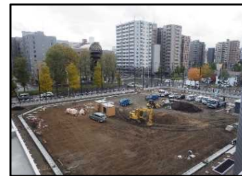
流域貯留施設の整備
