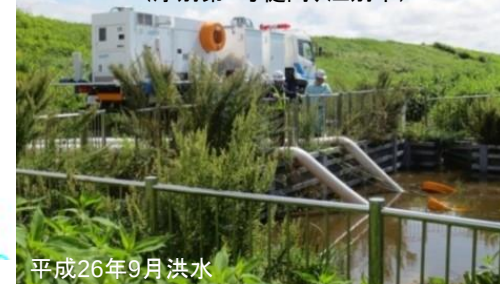
排水ポンプ車による内水排除状況 (厚別第2号樋門、江別市)
