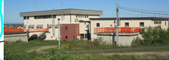
厚別排水機場 (農業) (S44完成 排水量4.0m 3 /s)
