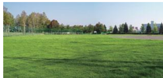
西岡中央公園 流域貯留施設 (豊平区 平成16年整備)
