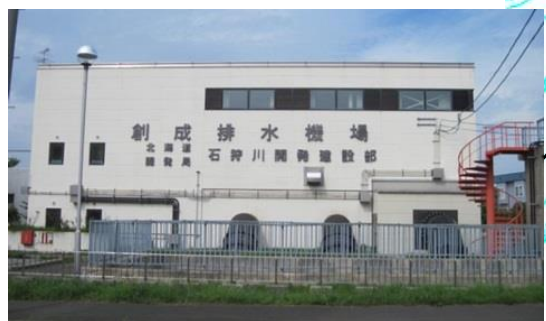
創成排水機場 (S59完成 排水量10.0m 3 /s)
