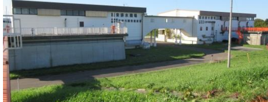
雁来排水機場 (S61完成 排水量20.0m 3 /s、H9増設 排水量10.0m 3 /s)
