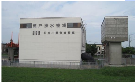
茨戸排水機場 (S59完成 排水量16.0m 3 /s)
