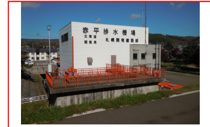
赤平排水機場
