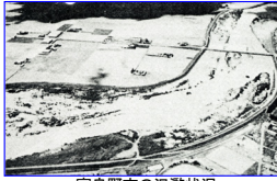
富良野市の氾濫状況
