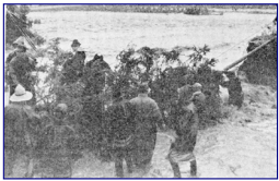
空知橋付近の堤防決壊による水防作業状況 出典：富良野市史
