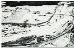
富良野市の氾濫状況
