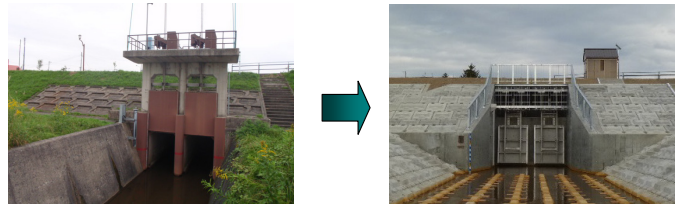
樋門ゲートの無動力化の例（自動開閉ゲート）
