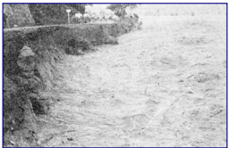
国道 38 号空知橋下流の決壊状況 出典：富良野市史
