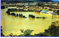
赤平市茂尻地区の浸水状況 (昭和 50 年 8 月洪水)
