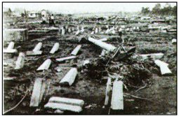
赤平市公営住宅流出後の状況
