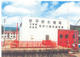
赤平排水機場
