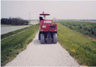
堤防天端の維持管理
