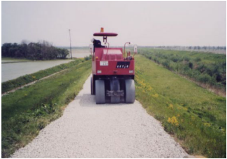
堤防天端の維持管理
