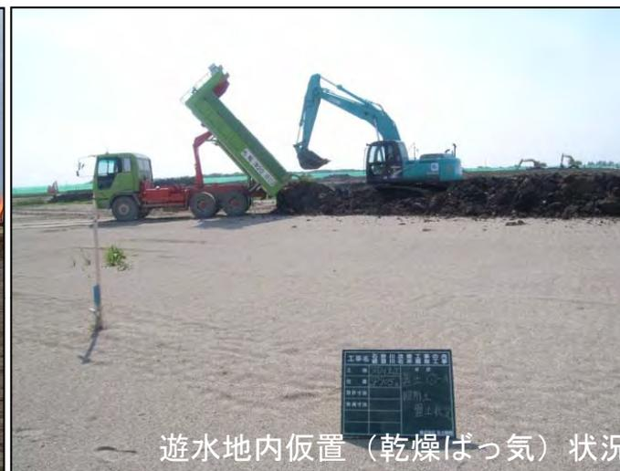
図6-2 遊水地掘削土の堤防整備への流用イメージ
