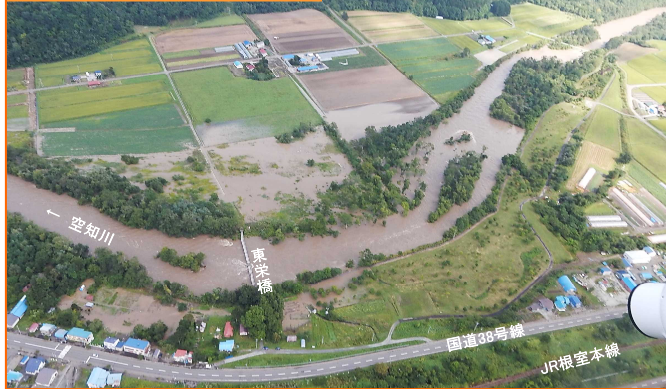
② ダム下流浸水状況 (KP100.0)
