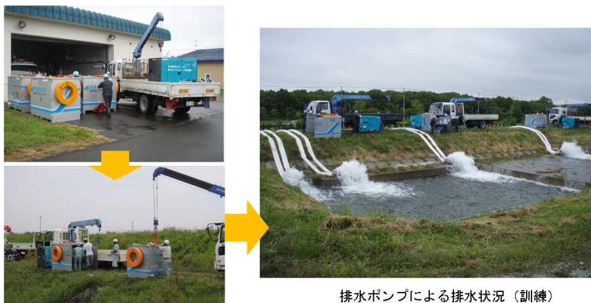
排水ポンプによる排水状況（訓練）
