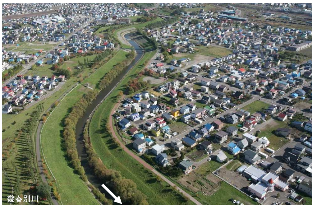
背後地に住宅が近接する箇所での管理用通路設置例
