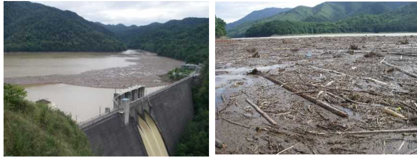
ダムサイトの流木状況写真
