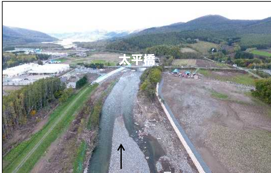
災害復旧工事前（緊急復旧実施中）
