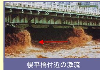
◆高速の流れにより河岸侵食及び高水敷洗掘が発生。
