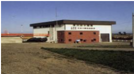
厚別排水機場（直轄） 昭和59年完成排水量 16m³/s
