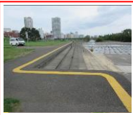
護岸の平滑化と点字タイル (幌平橋下流左岸) KP16.0
