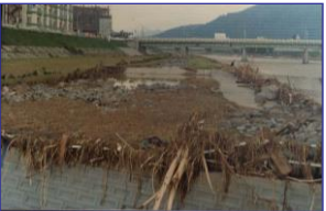
昭和56年（1981年）8月下旬洪水における高水敷の被災状況 (6号床止右岸下流)
