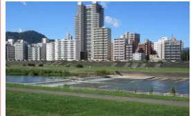
5号床止の魚道
