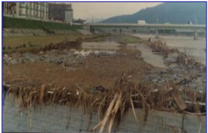
昭和56年8月下旬洪水における高水敷の被災状況 (6号床止右岸下流)
