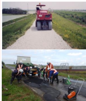
堤防天端の維持管理
