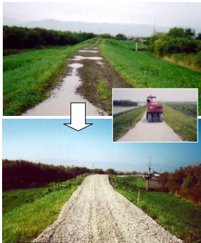
堤防天端の維持管理
