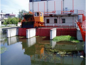
排水機場のゴミの除去
