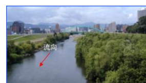
河道内樹木状況写真（東橋上流）
