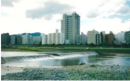
5号床止の魚道
