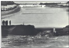
石狩放水路の緊急通水状況
