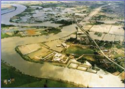
茨戸川の浸水状況
