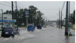
平成13年（2001年）9月冠水状況 (国道626号東米里付近)
