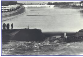
石狩放水路の緊急通水状況
