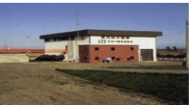
厚別排水機場（直轄） 昭和59年（1984年）完成排水量 16m³/s
