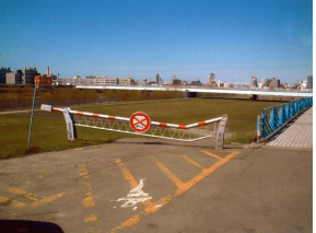
車止めの補修
