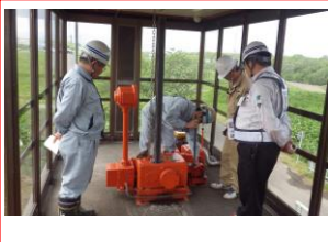
樋門の操作訓練
