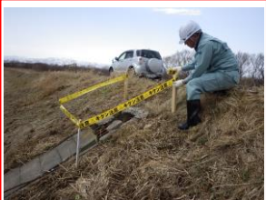
樋門施設の点検
