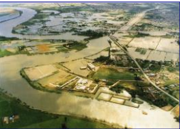
茨戸川の浸水状況
