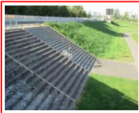
階段手摺り (幌平橋下流左岸) KP16.6
