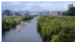
河道内樹木状況写真（東橋上流）
