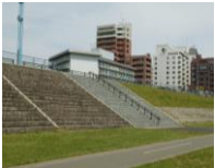
階段手摺り (幌平橋下流左岸) KP16.6
