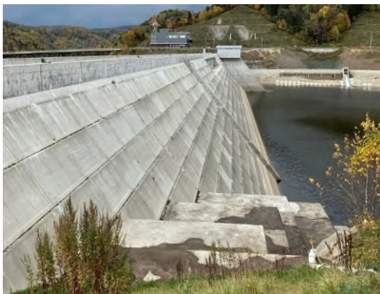
プレキャスト型枠による堤体表面と設置例
