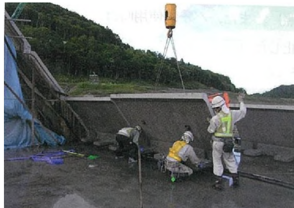
プレキャスト型枠による堤体表面と設置例
