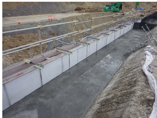
置き型枠による堤体表面と設置例
