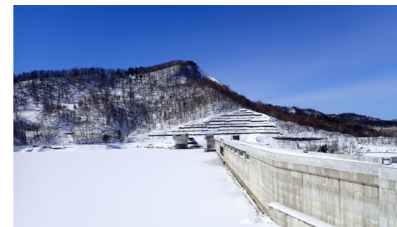
試験湛水終了水位 EL187.0m到達(3月8日)
