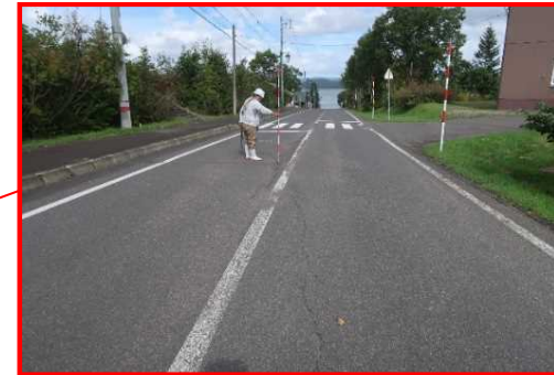
道路の路面に、段差を伴う亀裂が確認された。
