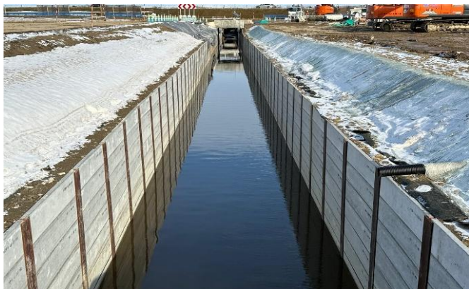
南5線集水路 完成 (R7年)
