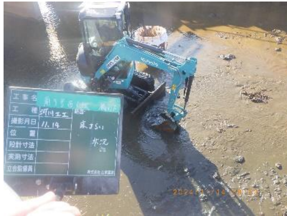
北島遊水地導水路床ざらい状況 (毎年実施)
