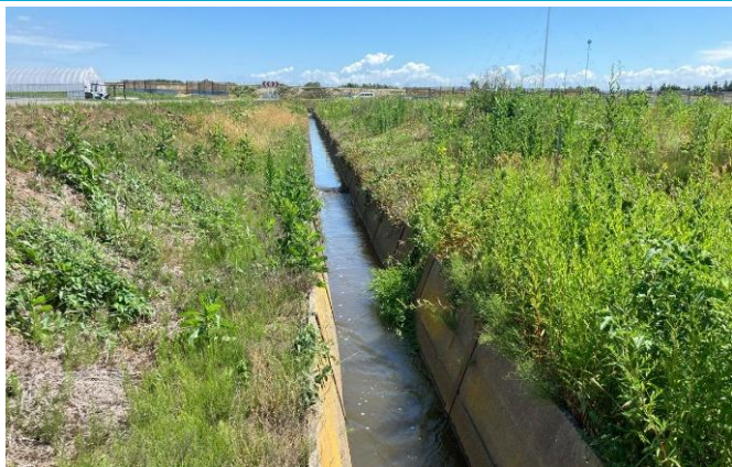
南5線集水路 着手前 (R7年)
