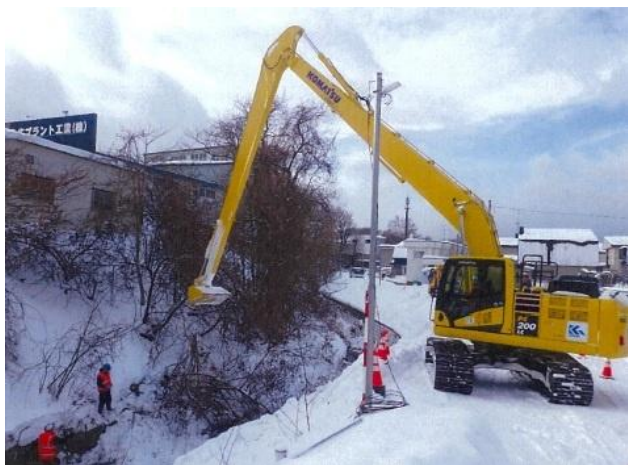
中の沢川浚渫
