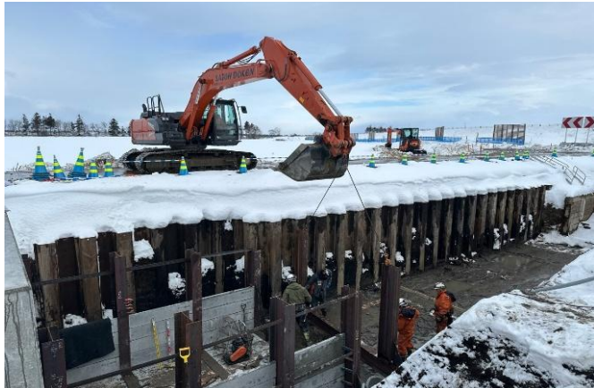
南5線集水路 施工中 (R7年)
