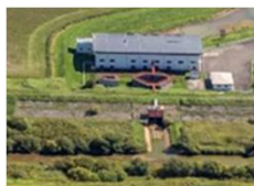
馬追運河排水機場
