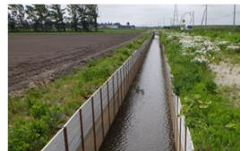
農業用の排水路整備
