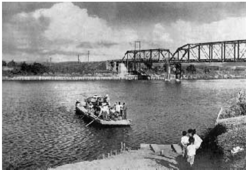
昭和17年の改修工事で復活した石狩川橋の渡船
